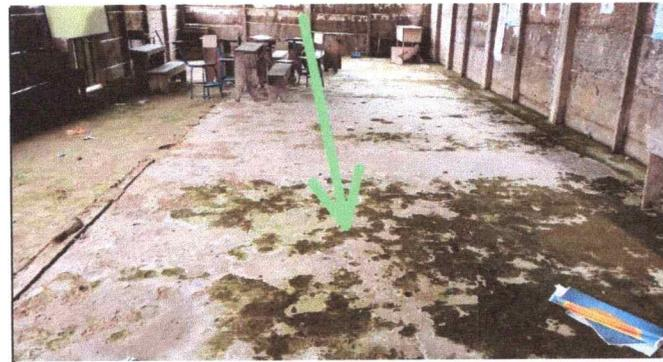
Foto 4: el piso ya esta deteriorado agrietados
